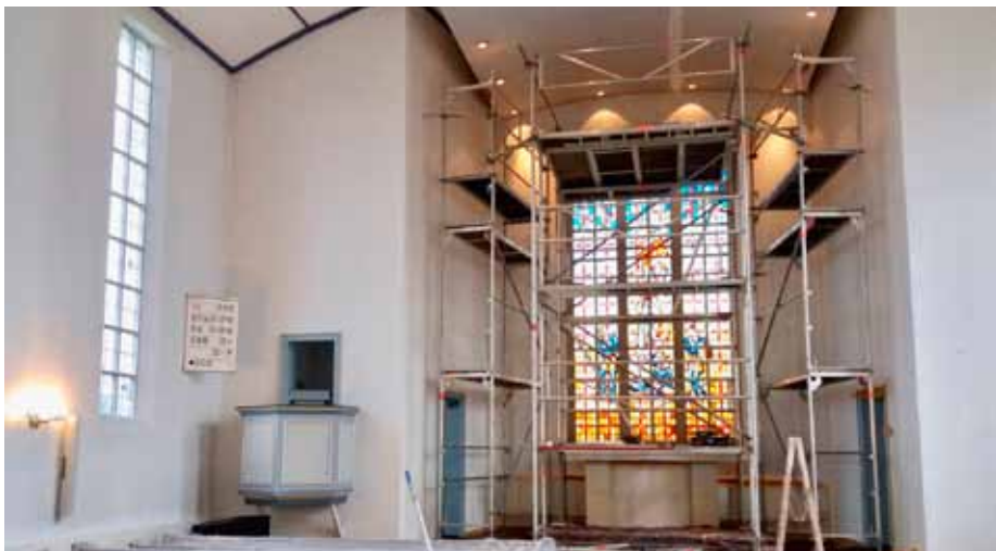
Abgedeckte Bänke und Gerüst im Altarraum
